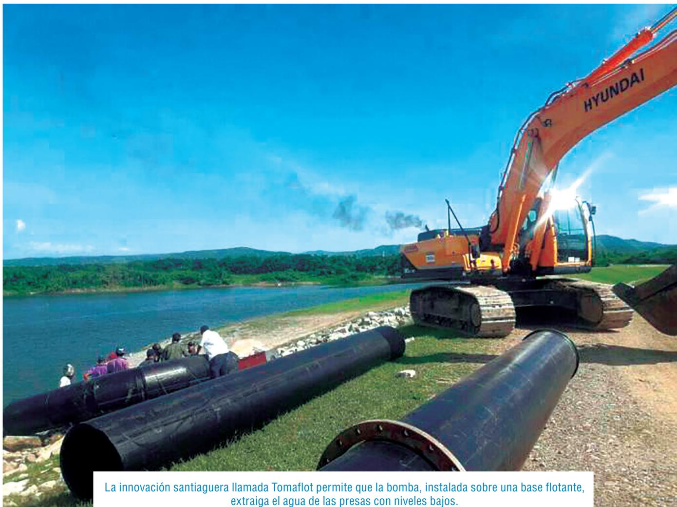
La innovación santiaguera llamada Tomafлот permite que la bomba, instalada sobre una base flotante, extraiga el agua de las presas con niveles bajos.
