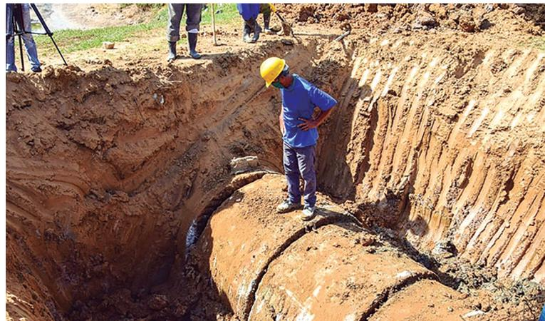
Se produjo un hundimiento por la zona, suceso que ocurre regularmente en este tipo de obras hidráulicas, y los trabajadores procedieron a excavar, revisar y sellar la tubería defectuosa, restablecer la tobera (que permite medir las entregas de agua) y compactar de nuevo el hidromecanismo.
