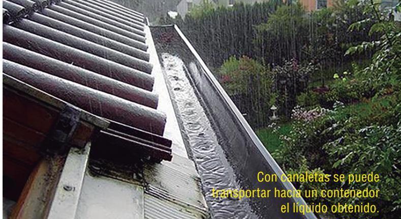
Con canaletas se puede transportar hasta un contenedor el líquido obtenido.
