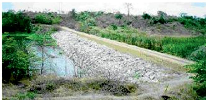
**Figura 29.** Fusible construido en la cola del embalse de la Presa Chongón, en Ecuador, aplicando el procedimiento del autor.
