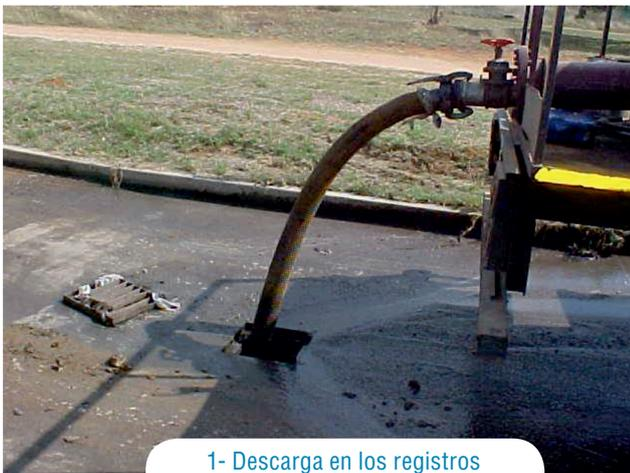
1- Descarga en los registros del alcantarillado.
