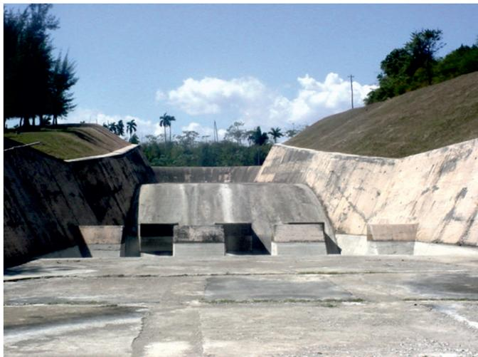
**Figura 30.** Estanque amortiguador del aliviadero Mosquito (Provincia de Artemisa).
