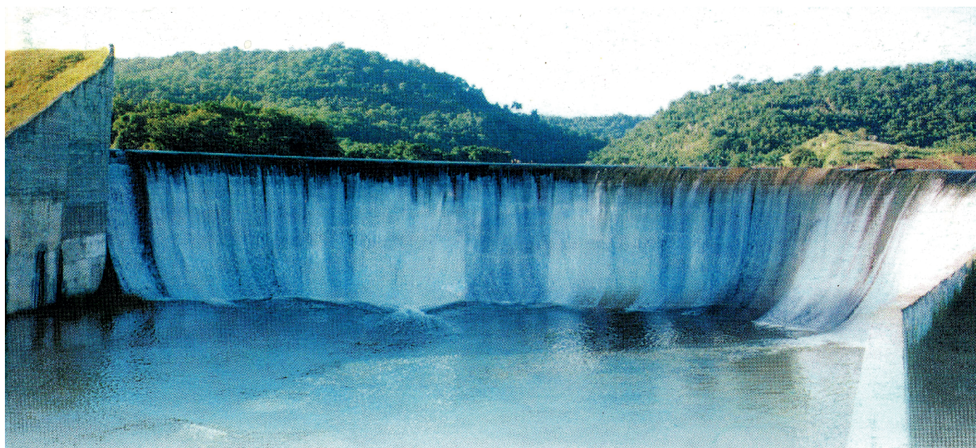
Vertimiento por el aliviadero del conjunto hidráulico Liberación de Florencia (Provincia de Ciego de Ávila) ( L = 80 m, H_o = 5,24 m, Q = 2\,180 m 3 /s, P_1 = 9,50 m), diseñado por el entrevistado en 1985 según su solución estrictamente analítica de los aliviaderos radiales supercríticos equipados con vertedores en arco.
