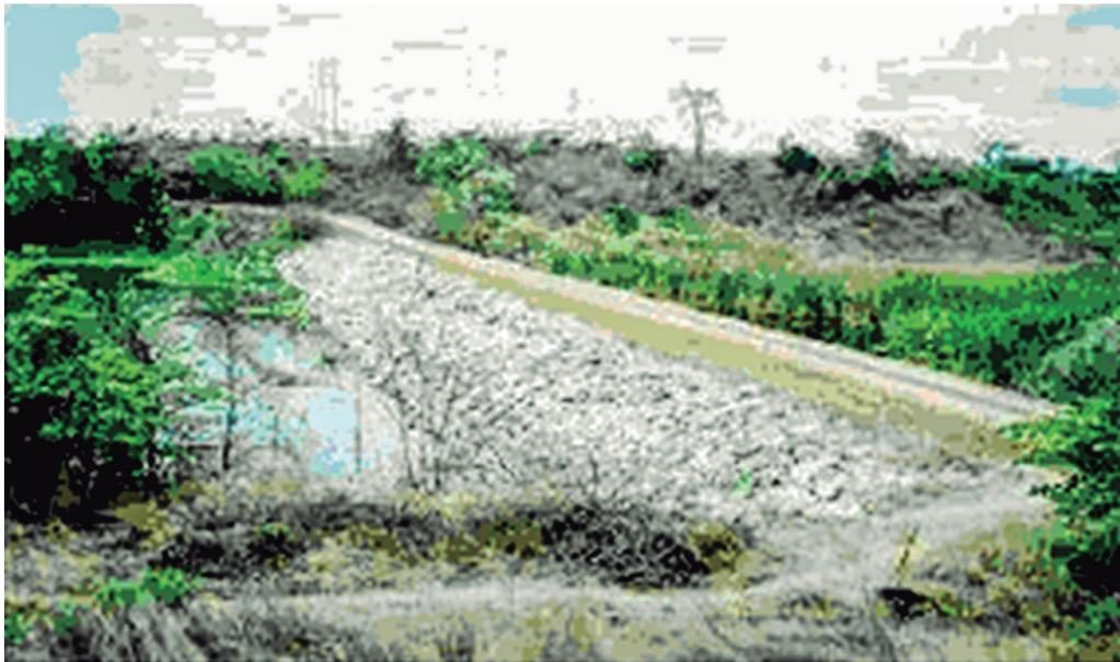
Figura 54. ALIVIADERO DE FUSIBLE EN LA PRESA CHONGÓN (ECUADOR)
